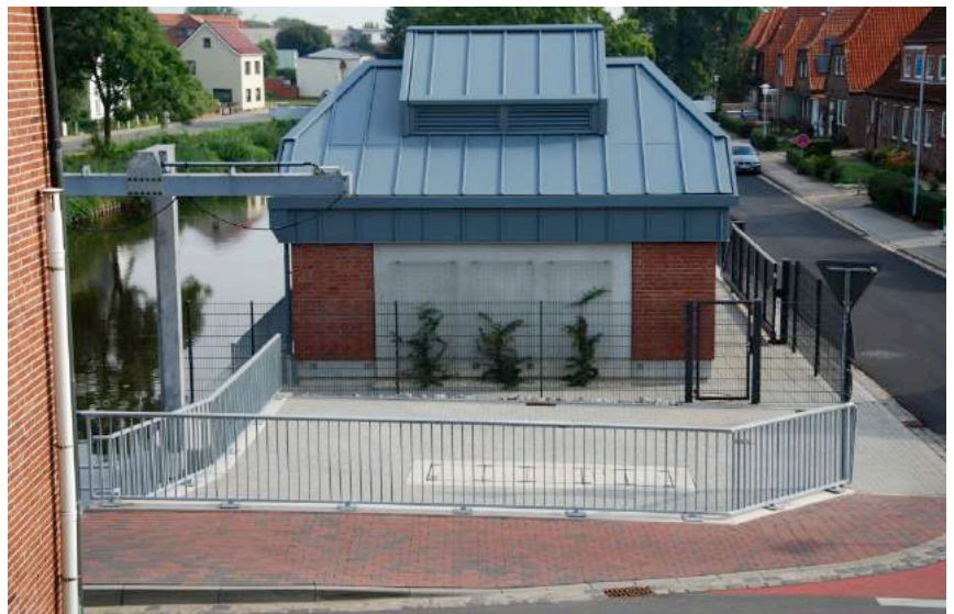
Abb. 3: Schöpfwerk Brunsbüttel-Nord, Neubau für eine Dritte Pumpe im Oktober 2013.
