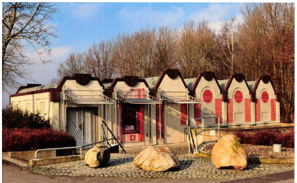
Abb. 9: Schöpfwerk Kudensee. Mit dem Schöpfwerk am Kudensee erprobt der DHSV eine neue Steuerungstechnik zum flexiblen Stromeinsatz.
