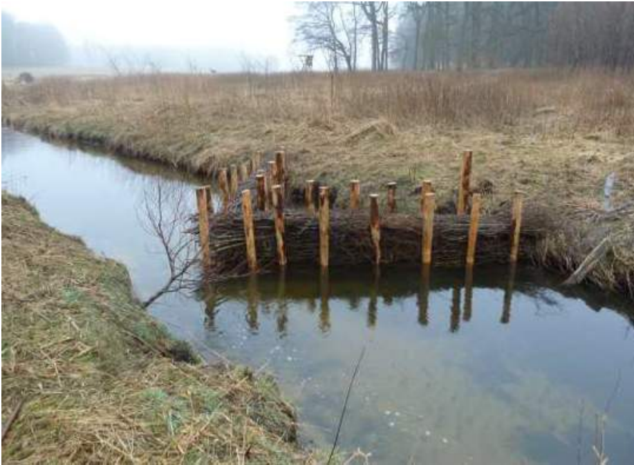
Abb. 6: Rantzau: Dreiecksbuhne kurz vor der Fertigstellung (04/2013)
