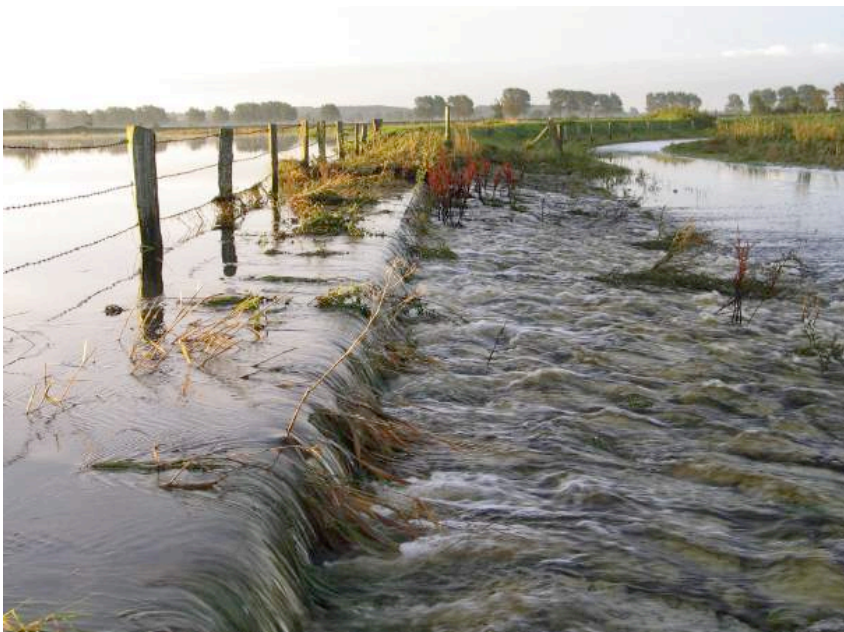
Abb. 7: Flutung eines Polders an der Treene zur Entlastung der Deiche.
