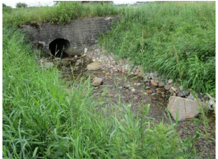
Abb.4: Rückbau von Sohlabstürzen durch den Wasserverband Bekau; hier: Absturz bei 0+378 am 5.7.2013.
